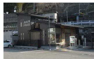
本庁舎横ポリステーション
